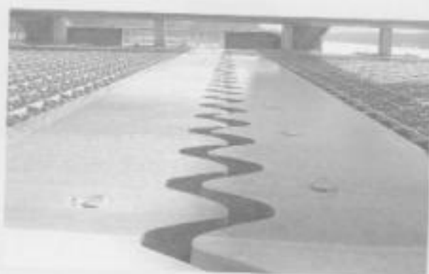
Giunto di dilatazione di un ponte metallico
