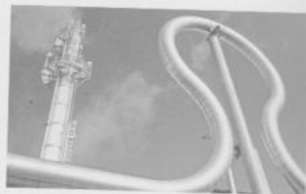
Compensatore di dilatazione a omega
